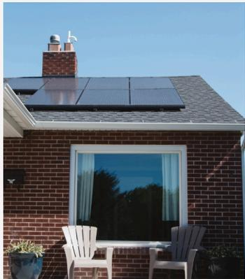
Photovoltaik-Anlagen lassen sich auf dem Dach von Häusern, Carports oder Garagen installieren und auch nutzen, um E-Fahrzeuge aufzuladen. Zu beachten ist, dass die Anlage nicht beschattet ist, durch Nachbargebäude, Schornsteine oder Bäume.
