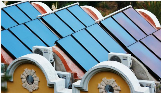
Für den Ertrag einer solarthermischen Anlage sind die Größe der Kollektoren, ihre Ausrichtung und Neigung sowie die Art der Heizung entscheidend.
