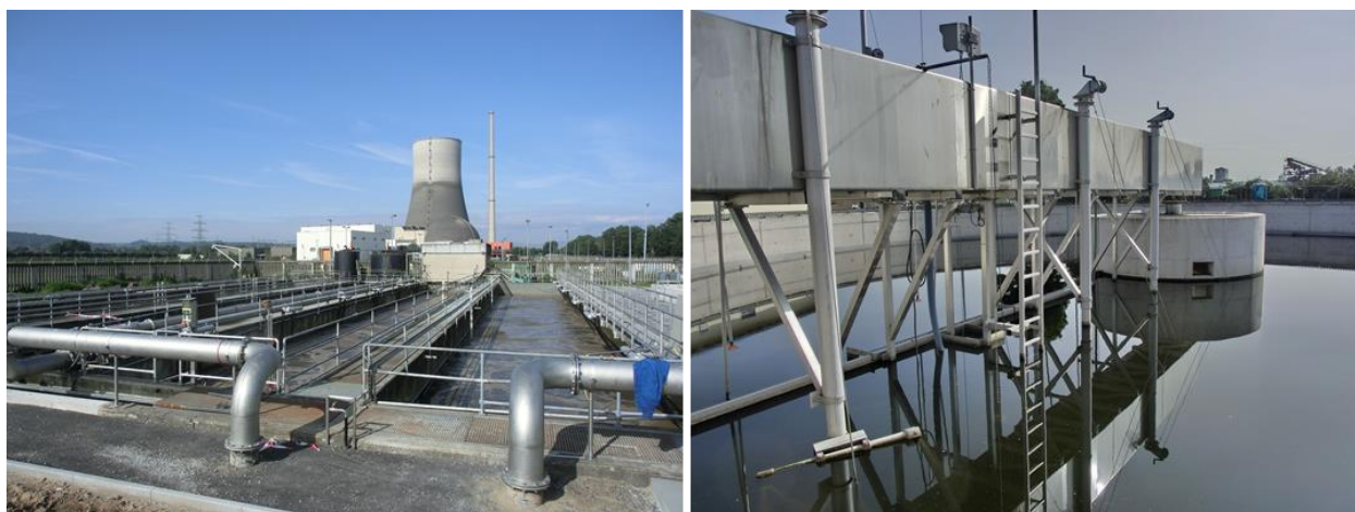
Abbildung 4-17 Klärwerk Urmitz / Bahnhof (Quelle: Bilder TSB)
