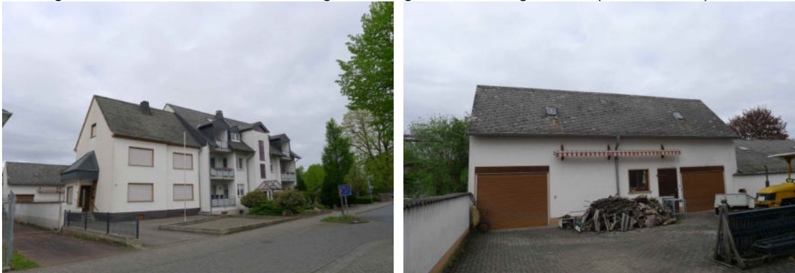
Abbildung 14: Wohnhäuser und vom Plangebiet tangiertes Nebengebäude (rechtes Foto)
