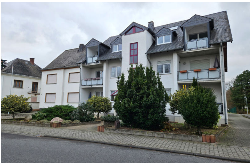
Blick von Süden auf die Bestandsgebäude entlang der Hauptstraße
