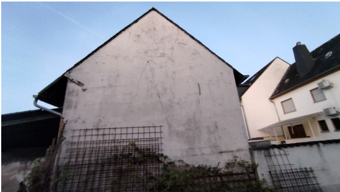
Blick auf das Nebengebäude Hauptstraße 2A von Westen aus
