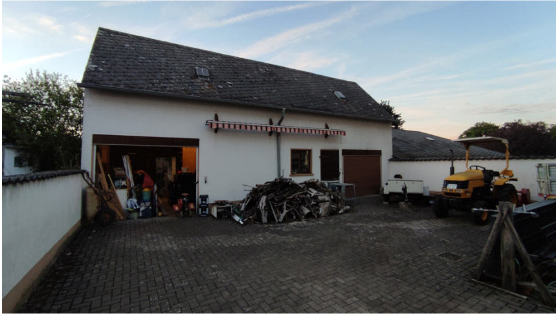
Blick auf das Nebengebäude Hauptstraße 2A (Abriss/ Teilabriss erforderlich zur Herstellung der Zufahrt)
