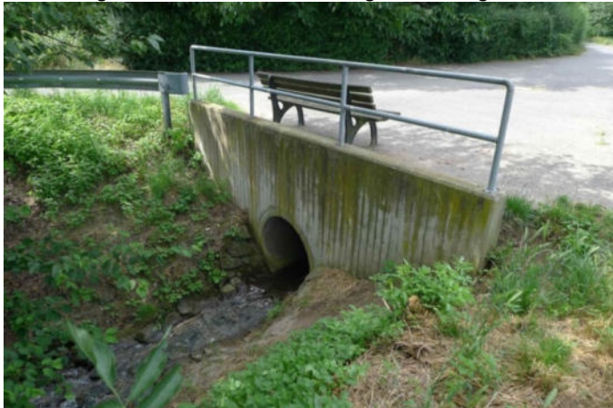
Abbildung 10: Ende der Verrohrung des Kettiger Bachs am nördlichen Rand des Plangebiets
