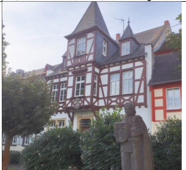
Walpot-Platz 12; sog. Rentamt, Fachwerkhaus, tlw. Massiv, 19./20. Jh.
