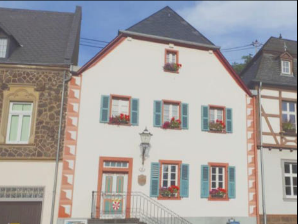
Walpot-Platz 3; Krüppelwalmdachbau, bez.1753
