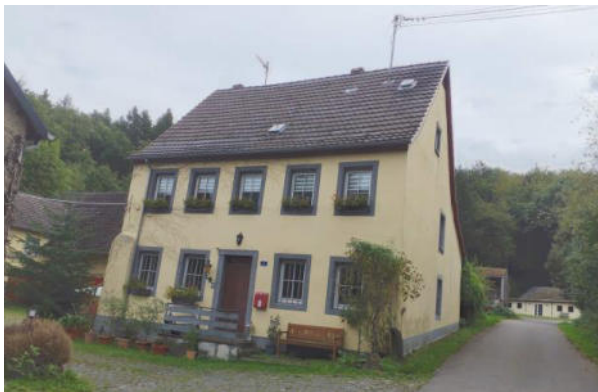
Historisches Gebäude mit Putzfassade – Hofanlage
