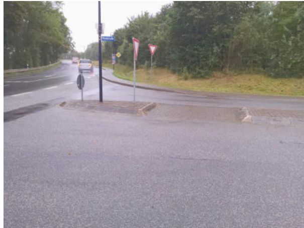
L 98 – Koblenzer Straße Kreuzung Waldstraße
