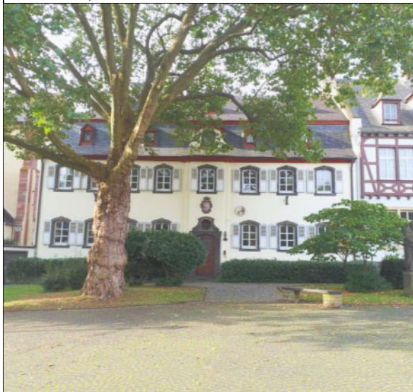
Walpot-Platz 11; achtschiger Mansardwalmdachbau, bez. 1781 und 1912
