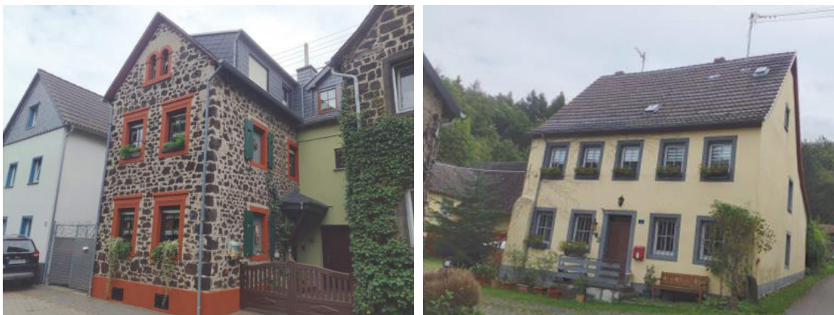
Beispielfoto für gut erhaltene/sanierte ortsbildprägenden Gebäude
