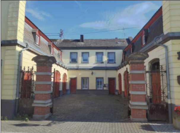
Mayener Straße 42; neubarocke U-förmige Hofanlage, Mansarddach, 2. Hälfte 19. Jh.
