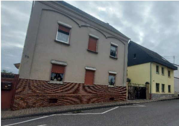
Abbildung 26: Bitumenschindeln (Bachstraße 5)
