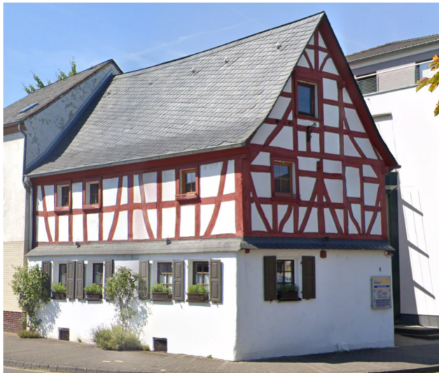
Fachwerk auf massivem Erdgeschoss, Schieferdeckung
