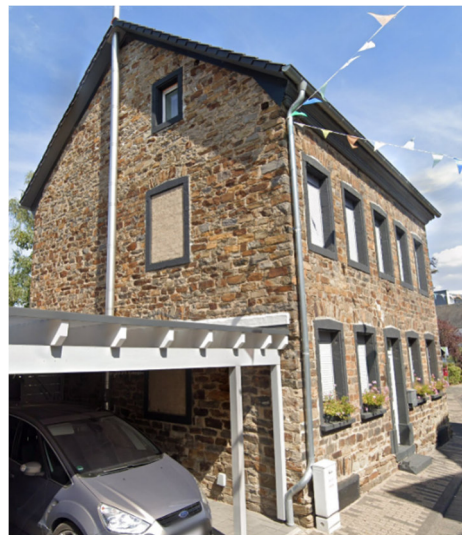
Natursteinmauerwerk Basalt-Tuffstein, Sandstein)
