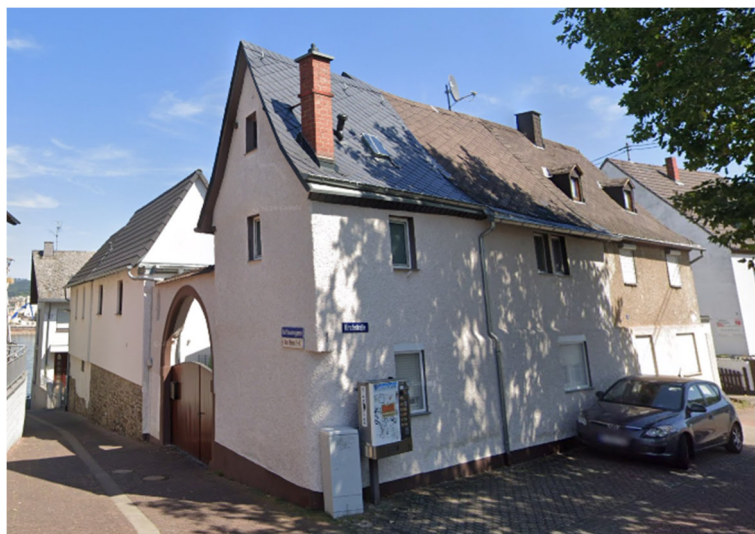
Hofreite, zwei Fachwerkhäuser, Torbogen, 19. Jahrhundert (Kulturdenkmal)
