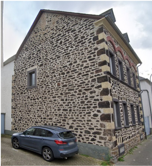
Natursteinmauerwerk Basalt-Tuffstein, Sandstein)
