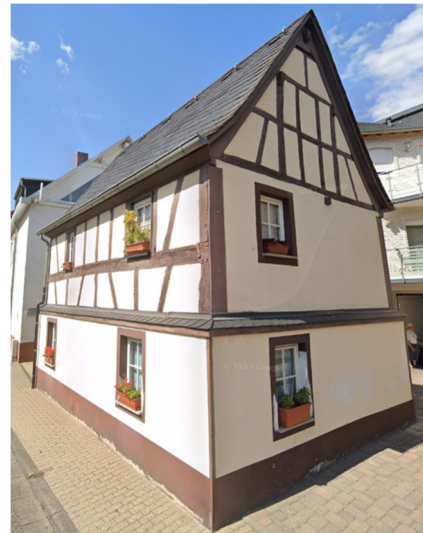
Fachwerk auf massivem Erdgeschoss, Schieferdeckung
