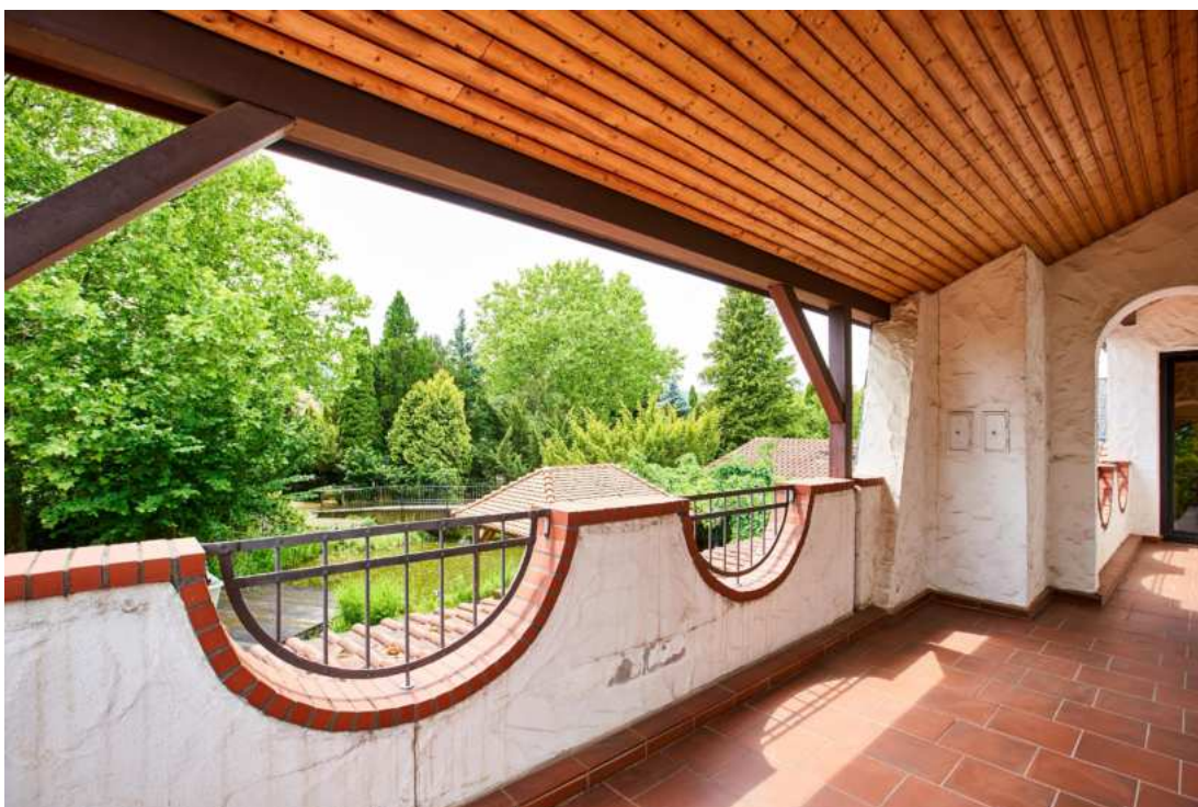
Wohnhaus 1.OG Terasse
